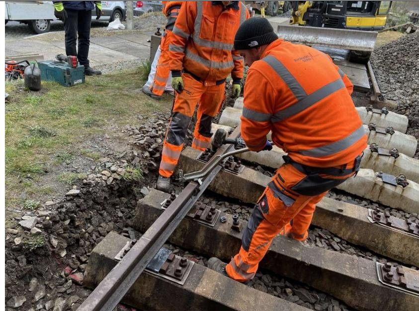
Nach dem Setzen der ersten Schiene erfolgt die Ausrichtung der Schwellen (AT)
