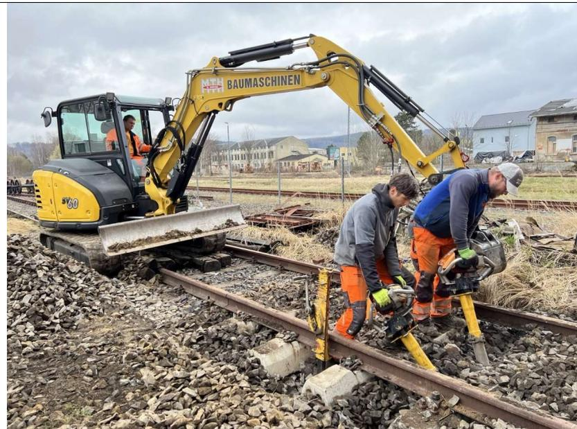
Nachdem alles ausgerichtet und verschraubt ist, wird gestopft und aufgefüllt (AT)
