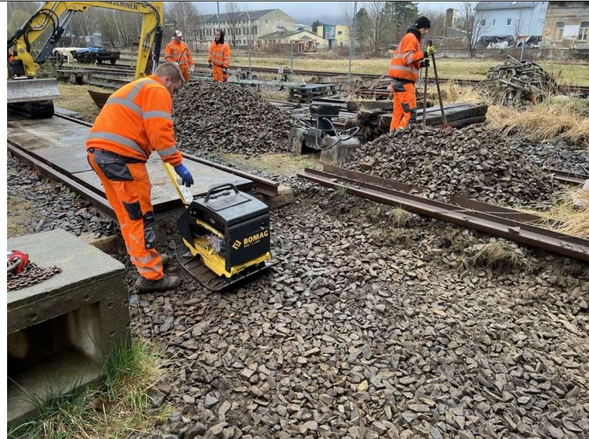
Vorbereitung des Schotterbetts beim Gleisbau an der Lokschuppeneinfahrt (AT)
