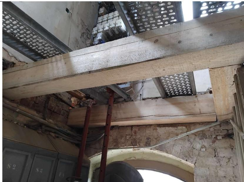
Eingebaute Balken des Zwischenbodens (AT)
