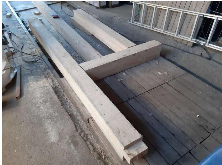
Weitere vorbereitete Balken liegen zur Instandsetzung des Zwischenbodens des Stellwerks W1 in Neustadt bereit. (AT)
