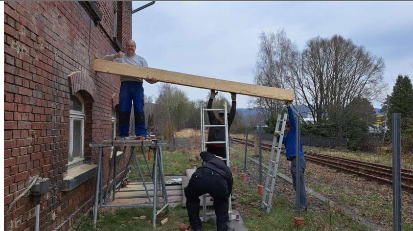
Einschieben eines Balkens des Zwischenbodens in das Stellwerk W1 (AT)
