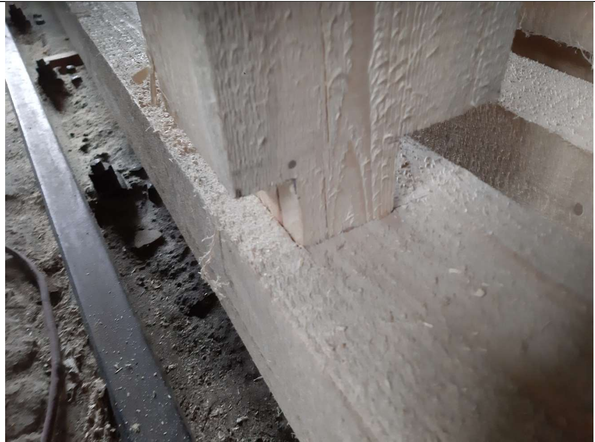
Bei der ersten Passprobe waren wir noch zu zaghaft, wir mussten später den Zapfen nochmals nachbearbeiten. (AT)
