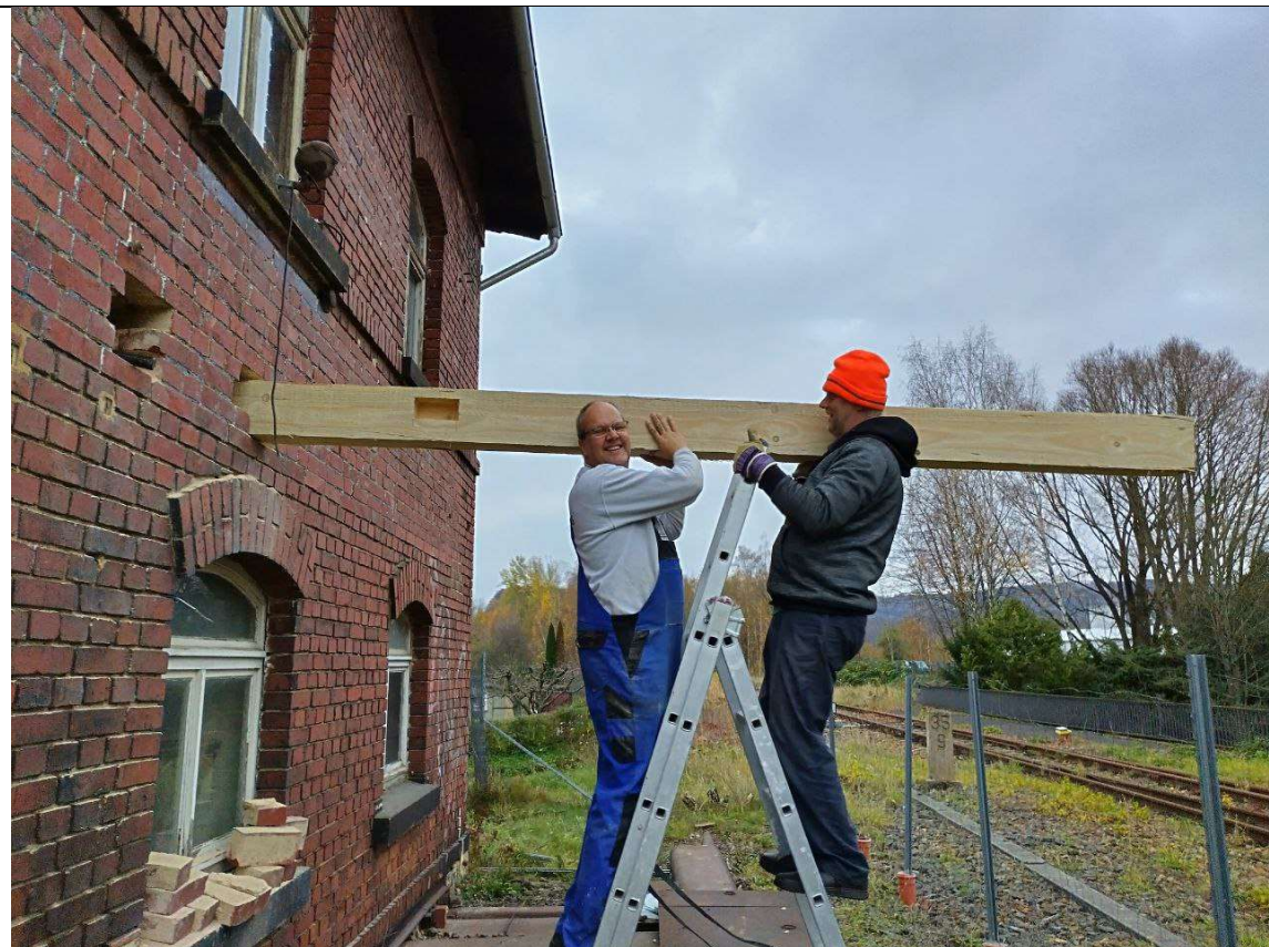
Mittlerweile haben die ersten neuen Balken den Weg ins Gebäude gefunden. (AD)
