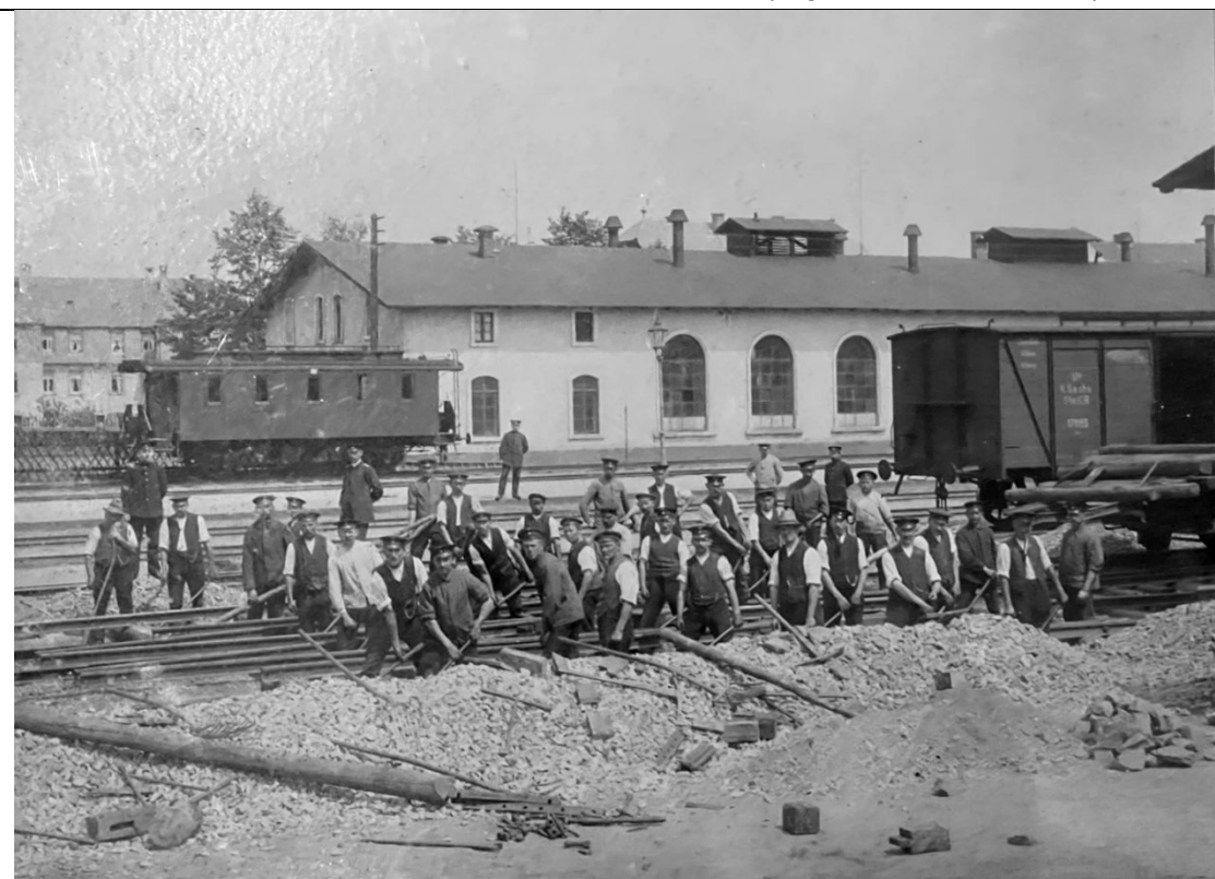
Gleisbau und Lokschuppen in Neustadt (Zeitraum ca. 1910 bis 1920). (Slg. ISEG)
