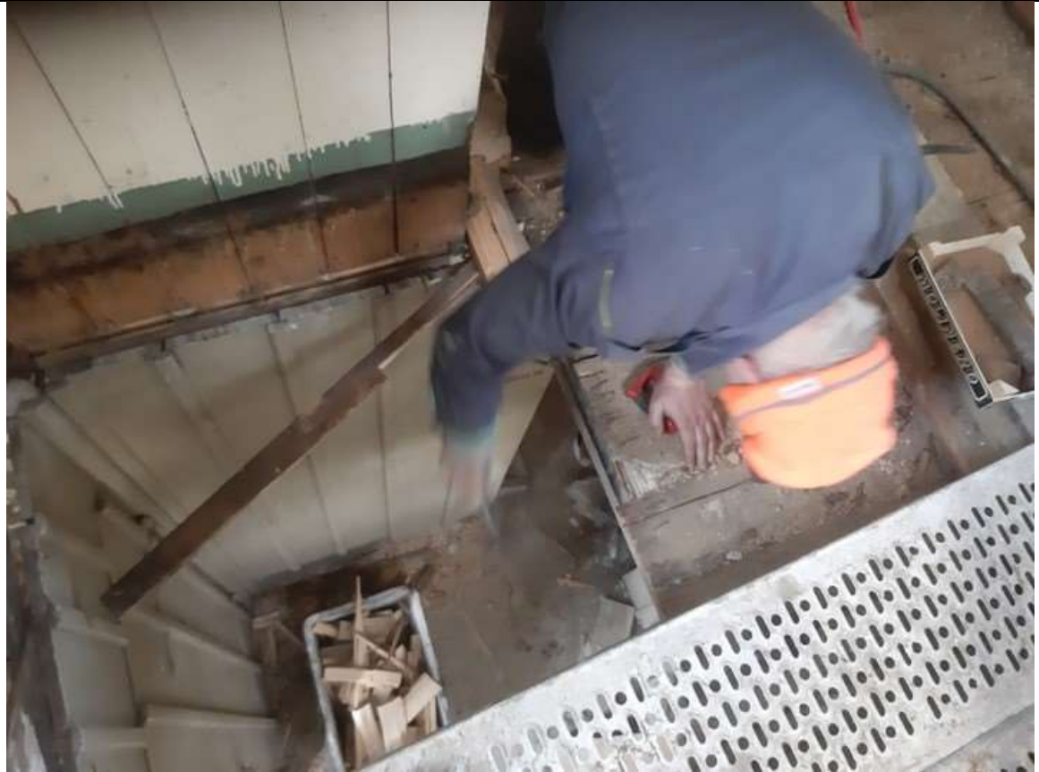
Nur mit massiven Aufwand konnten die alten Balken von Treppenhaus und Brüstung getrennt werden. Ein Teil wird noch als Feuerholz genutzt. (AT)
