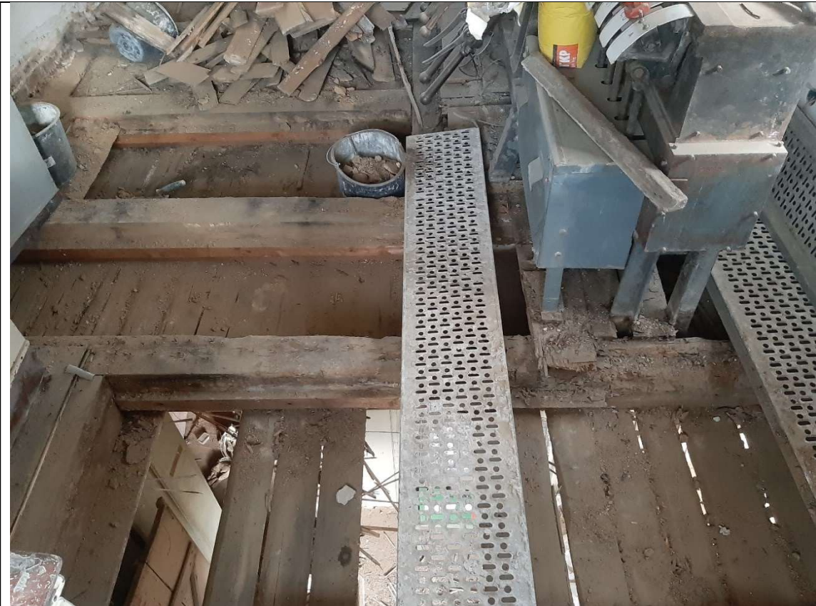
Leider nur eine kurze Atempause bei der Sanierung. Nur wenig später war der Fußboden des Obergeschosses herausgenommen. (AT)
